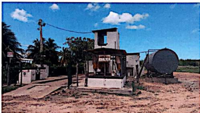
Fotografia 09 - Casa de Calda
