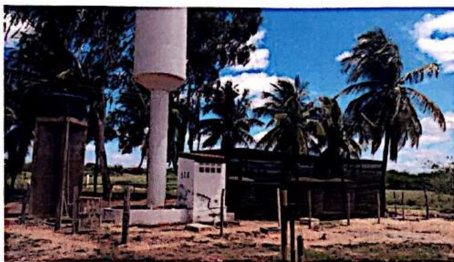
Fotografia 08 - Estação de Tratamento de Água
