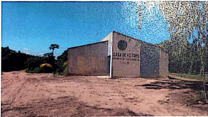
Fotografia 04 - Estrutura da casa de Filtro
