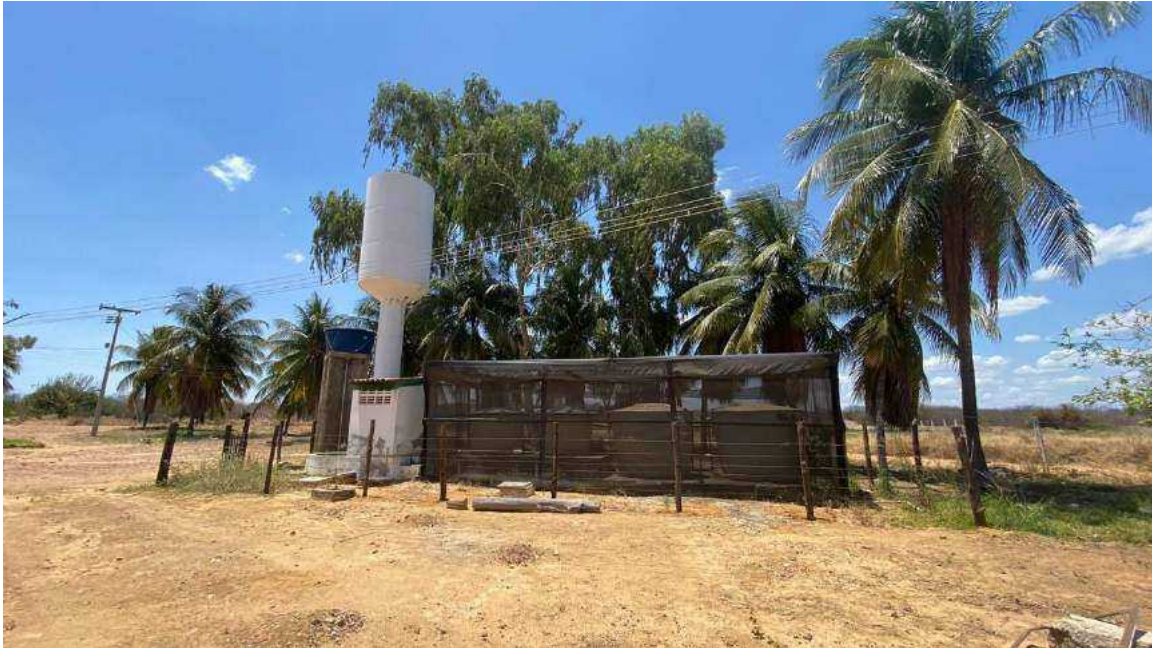
Foto 5: Estação de tratamento de água
