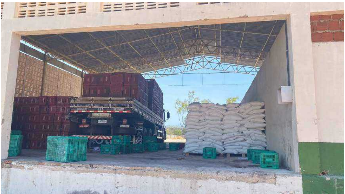
Foto 12: Área interna depósito
