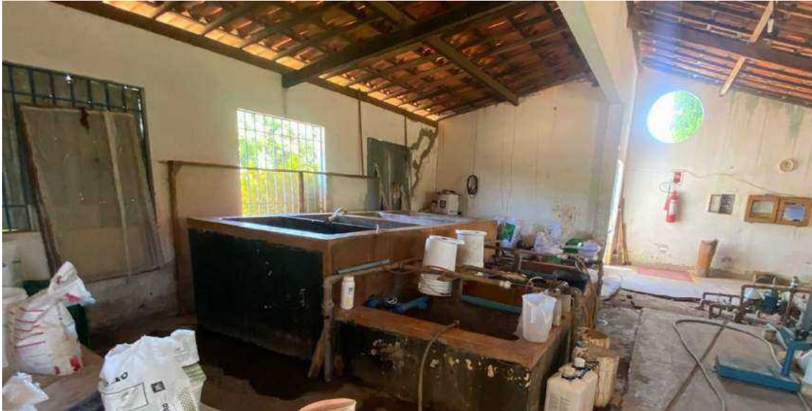
Foto 15: Casa de filtro 2, tanques de fertirrigação
