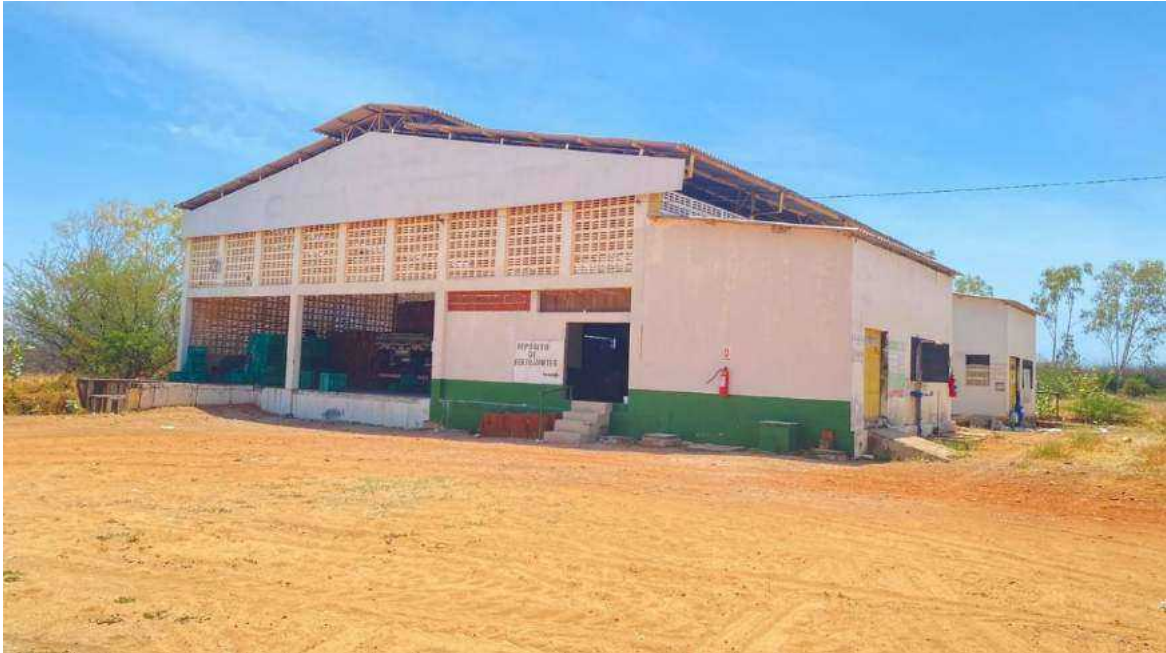
Foto 11: Área externa do depósito de fertilizantes
