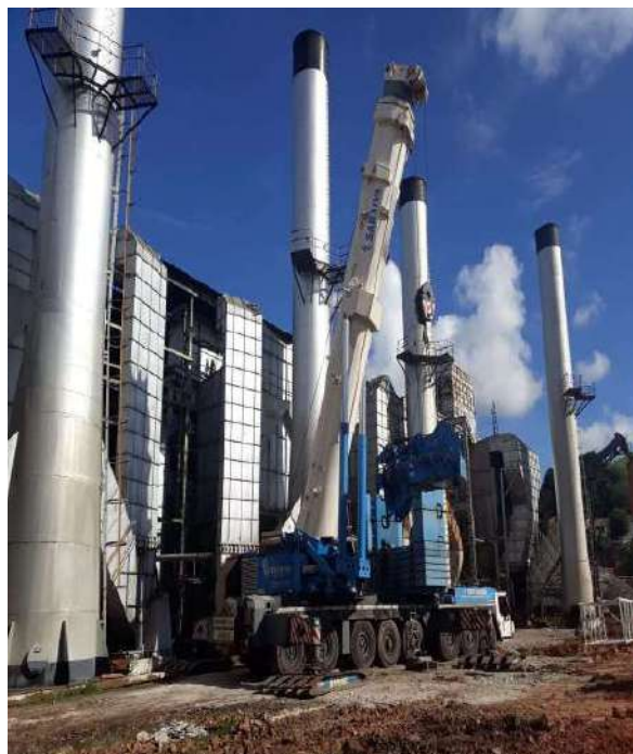
Figura 12 – Obra Usina Trapiche
