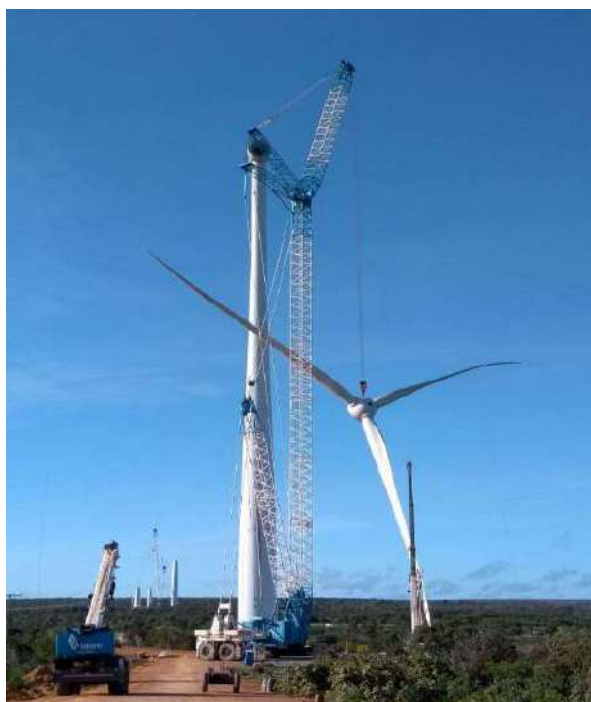
Figura 9 - Obra WEG – TIANGUA
