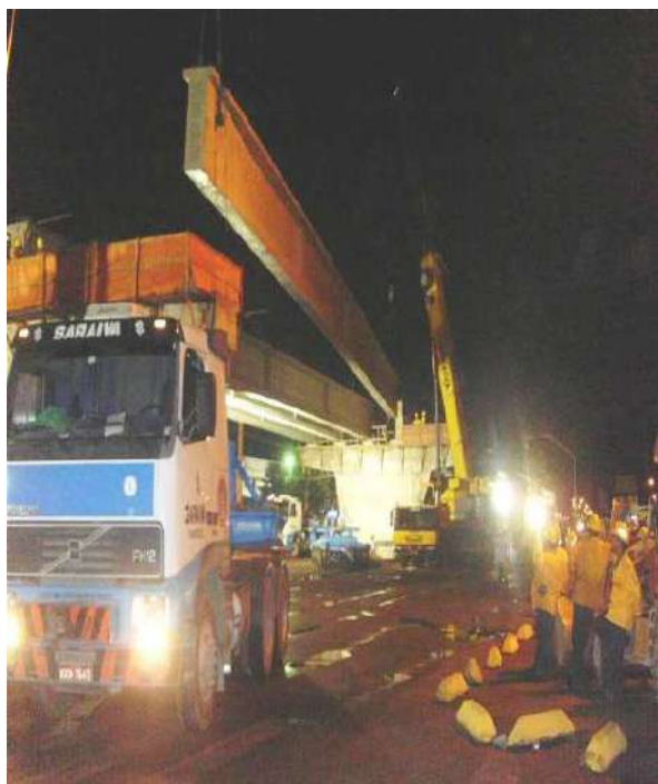
Figura 3 - Construção do viaduto em Prazeres – Jaboatão
