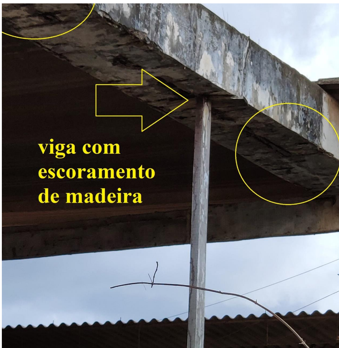
Figura 4 - Viga escorada com madeiramento
