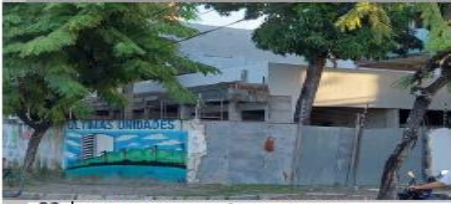
02 | REVESTIMENTO CERÂMICO FACHADA
