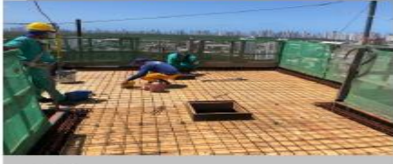
04 | LAJE RESERVATÓRIO SUPERIOR (TAMPA)
