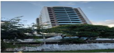
01 | REVESTIMENTO CERÂMICO FACHADA
